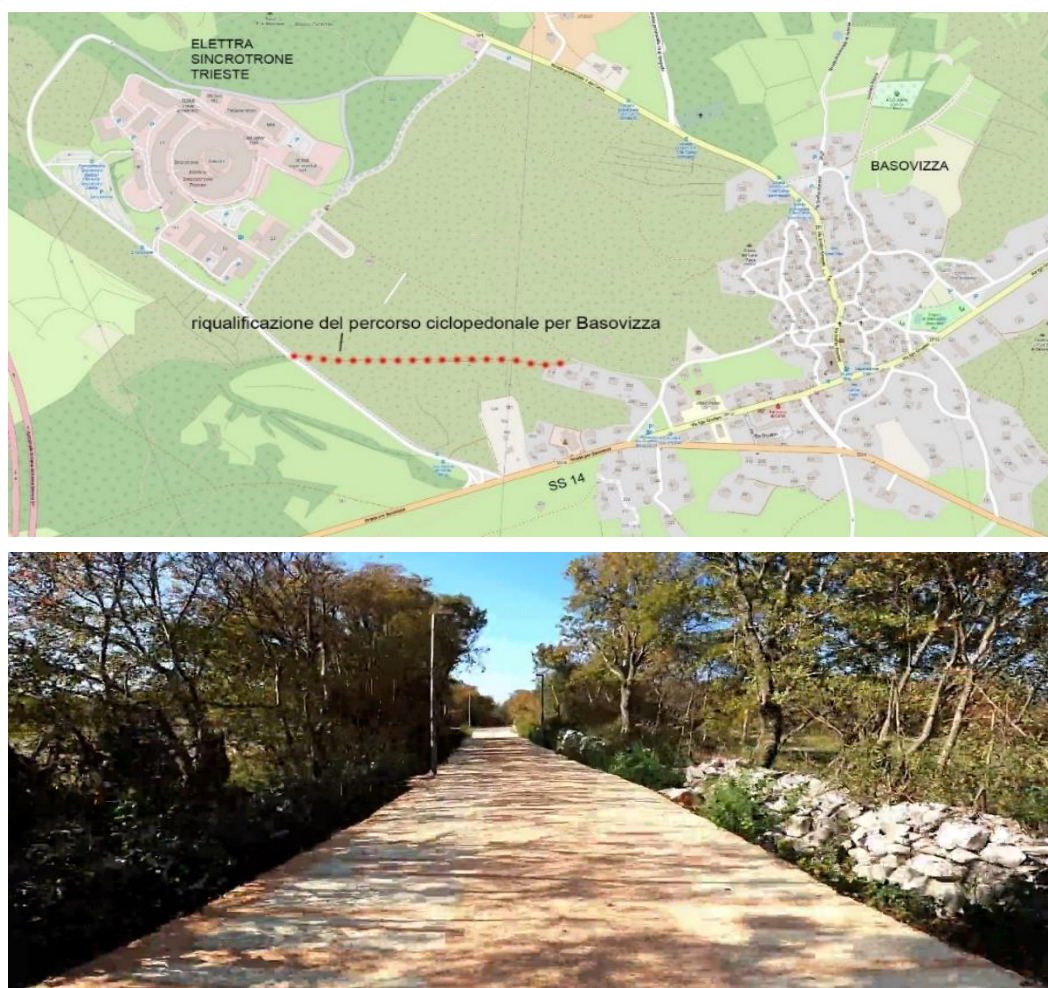
Figura 13 - Il percorso ciclopedonale riqualificato ed il suo tracciato.
