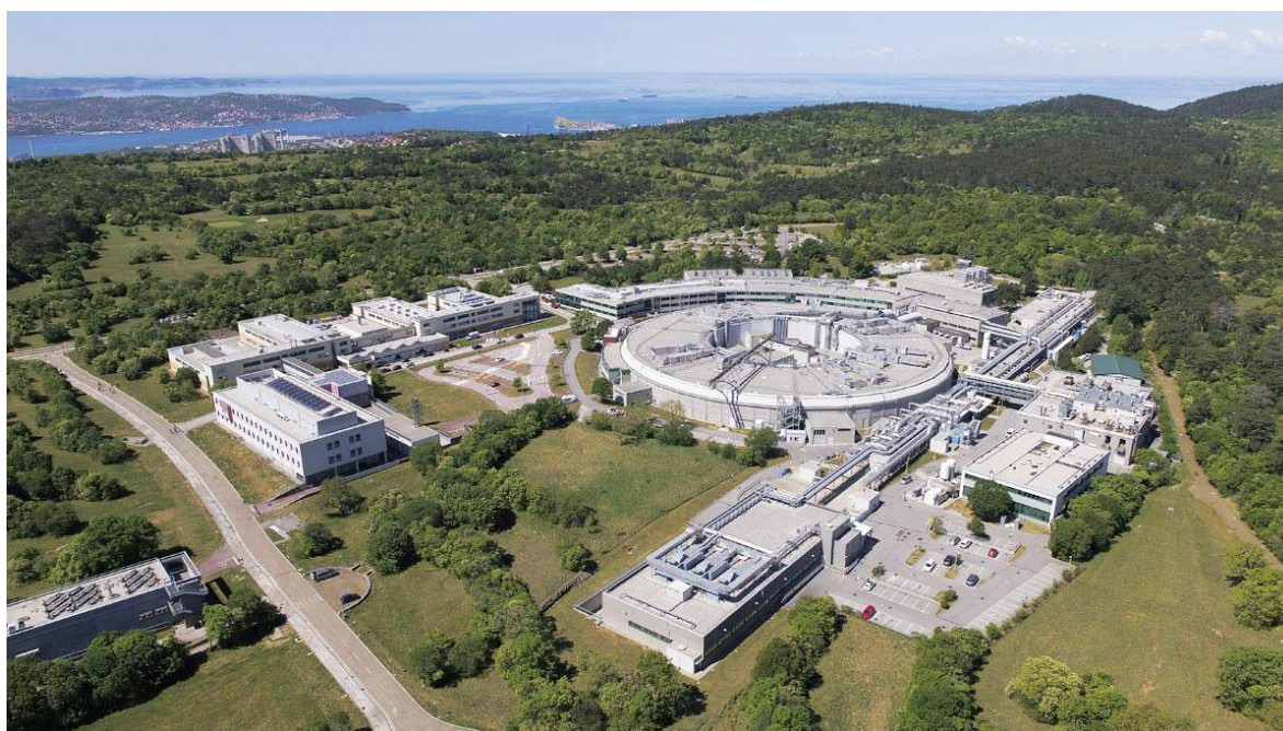
Figura 1 - Vista aerea del comprensorio di Elettra Sincrotrone.
