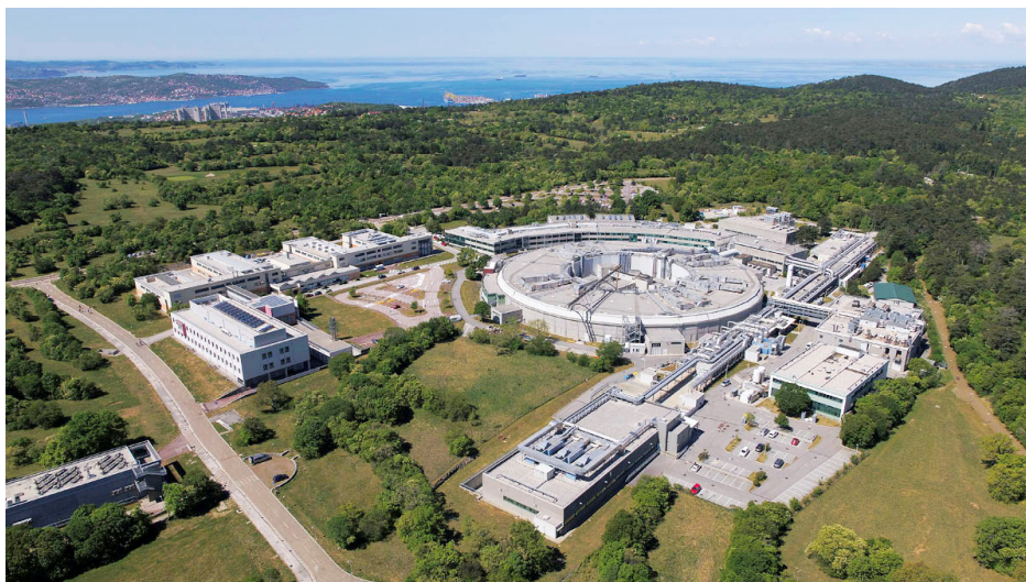
Figura 1 - vista aerea del comprensorio di Elettra Sincrotrone
